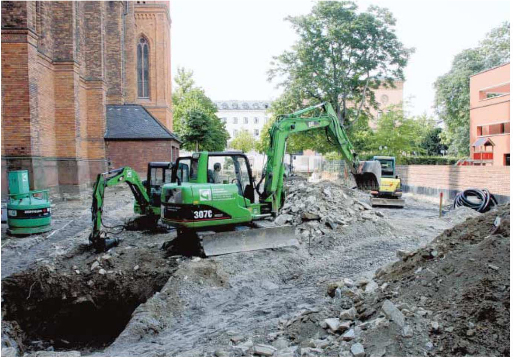
Hier wird fleißig gepflastert: Der Verbindungsweg zwischen Marktplatz und Schloßplatz führt an Marktkirche und Kindergarten vorbei.
