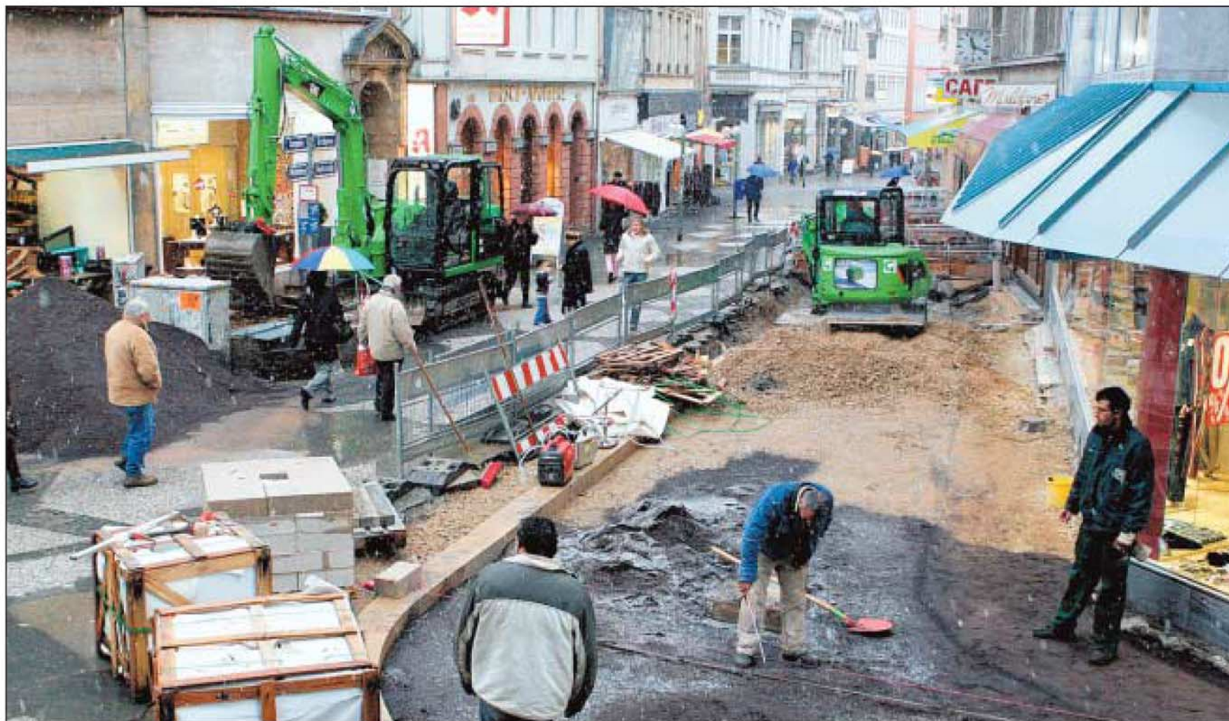
Lieferfahrzeuge müssen draußen bleiben: In der Marktstraße bleibt es wegen der Bauarbeiten auch die nächsten Monate lang eng.
